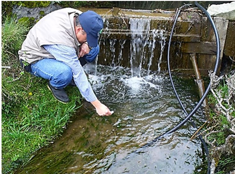
Figura 4. Presencia de una barrera artificial colocada en el lecho de un río de páramo (muro de represamiento).
