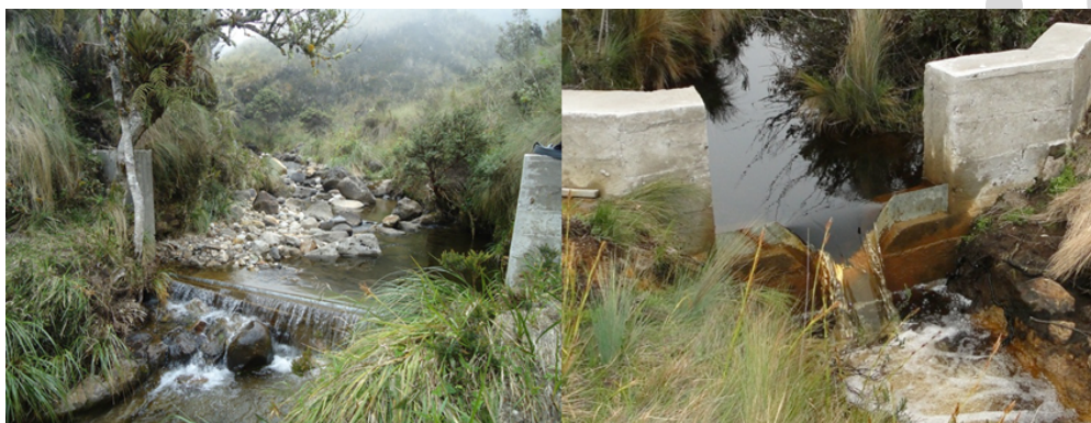
Figura 2. Ejemplos de un vertedero rectangular (izquierda) y de un vertedero compuesto (muesca en V - rectangular) (derecha) en la zona de estudio.
